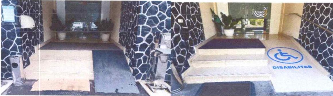
Gambar 30. Perbaikan Jalur Disabilitas menjadi permanen dan landai dilengkapi *handrail*
